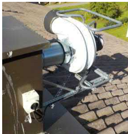
Pakokaasuimurin sähköistystä vesikatolla
