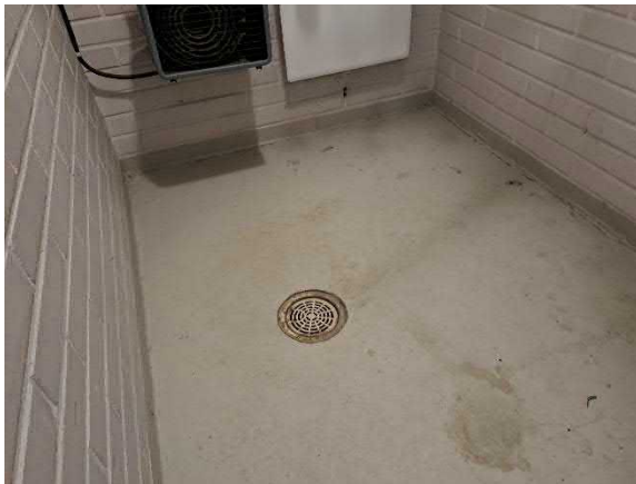
Halliosalla kuivaushuoneen pintamateriaaleja
