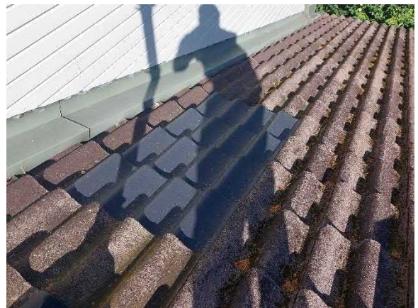
Kattotiiliä vaihdettu
