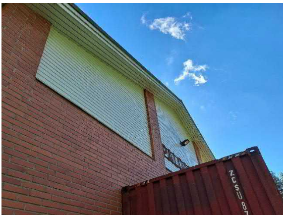
Yleiskuva halliosan laajennuksen päädyssä
