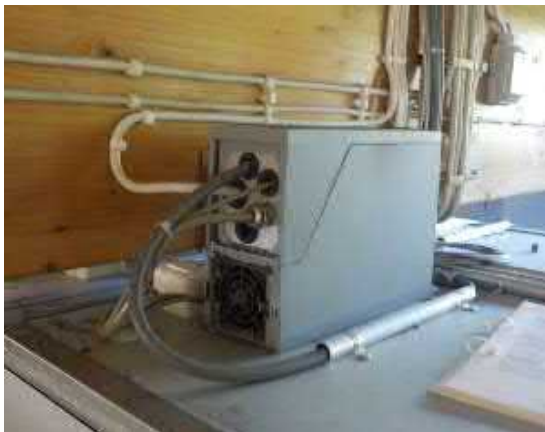
IV-koneen sähköistystä kalustohallin parvella
