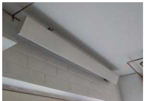
Säteilylämmitin verstaassa
