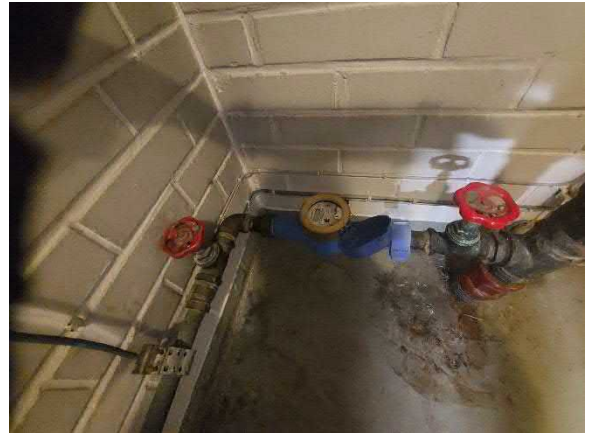
Kiinteistön päävesimittari.
