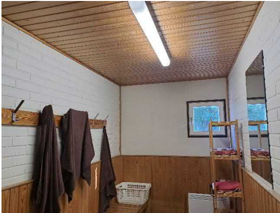
Tiilirakenteisia väliseiniä matalammalla osalla
