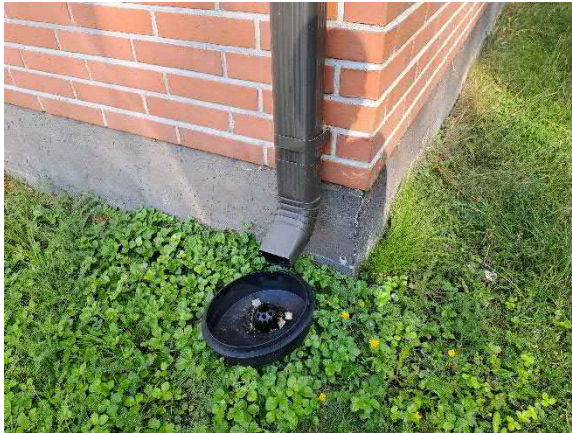
Kiinteistön sadevedet johdettuna rännisyöksyä pitkin rännikaivoon.
