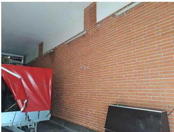
Kalustovaraston ja halliosan välinen seinä on vanha ulkoseinä
