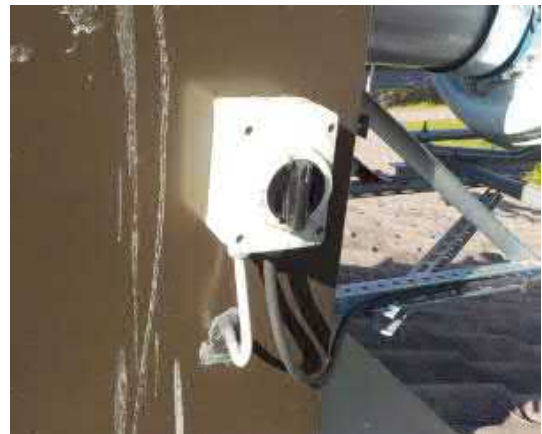
IV-koneen läpivienti vesikatolla
