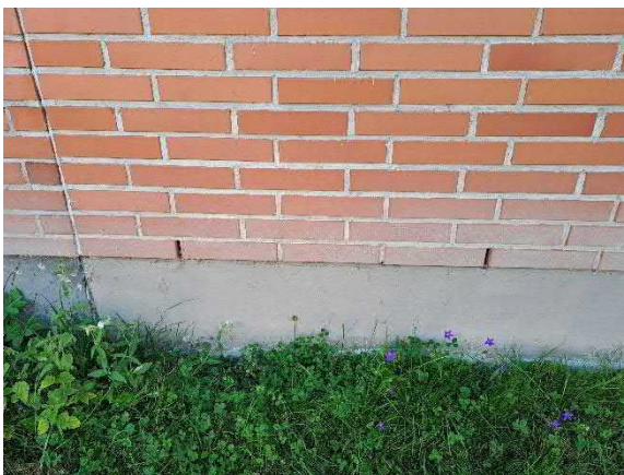
Nurmikkoa/kasvillisuutta kiinni sokkelirakenteissa, joissa paikoitellen viitteitä kohonneesta kosteusrasituksesta
