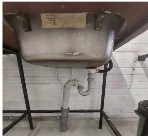
Alkuperäinen pesualtaan vesilukko.
