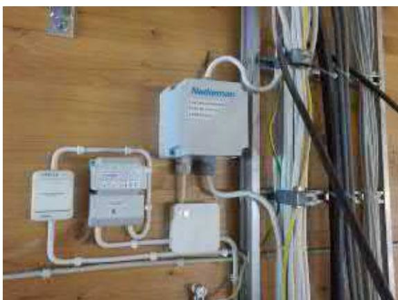
Pakokaasuimurin sähköistystä kalustohallin parvella
