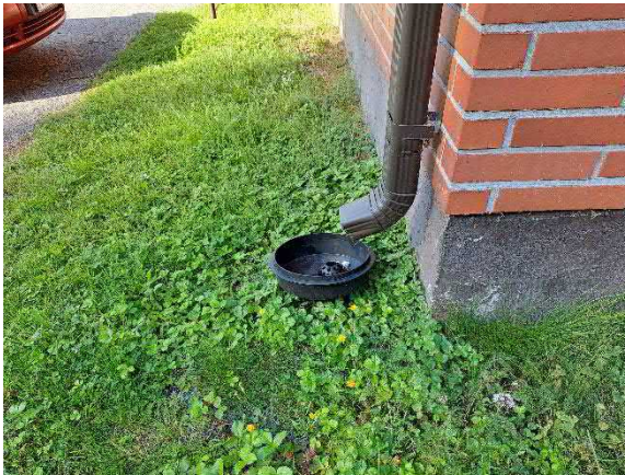
Sadevedet ohjataan osittain suoraan sadevesikaivoihin
