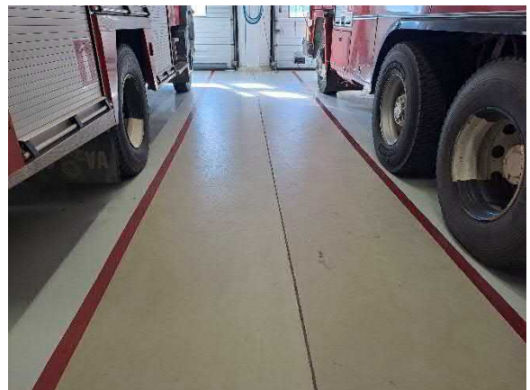
Halliosan lattiapinnoitteita on uusittu v. 2021
